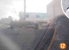
▲「循環注水冷却」の塩ビホースは応急処置
